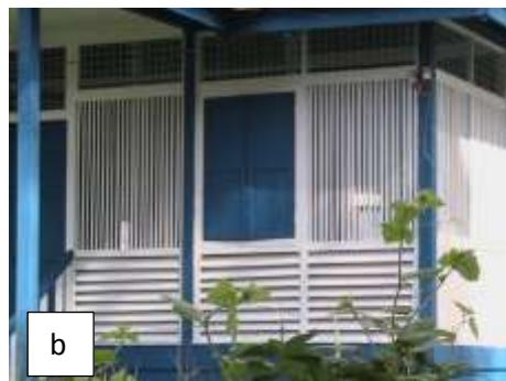
Gambar 15 : menunjukkan dinding bernafas bagi memberar aliran udara secara semulajadi berlaku. Gambar 15a adalah contoh dinding Serambi pada rumah warisan Melayu, manakala Gambar 15b adalah contoh dinding Serambi pada senibina Kolonial di Tanah Melayu.
