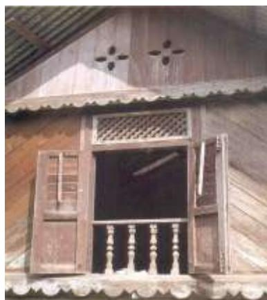
Gambar 16: menunjukkan buaan pada tebar layar yang memberi lauan kepada udara panas keluar dengan cepat dan menggalakkan berlakunya pengudaraan silang.
